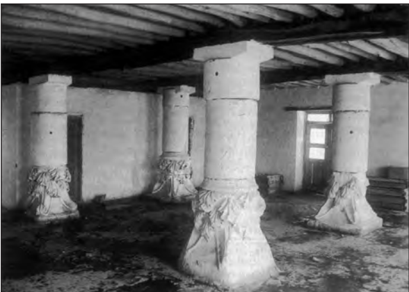
Рис. 33. Долина Ай-Ханум. Чайхана при доме Ходжи Бахауддина. Греко-бактрийские коринфские капители из раскопок Ай-Ханум, в перевернутом виде служащие вместе с барабанами колонн опорами устоев.
